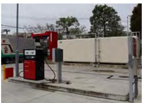
軽油の計量器。国内ではまだ導入がめずらしい屋外タンク(奥)を採用している。
